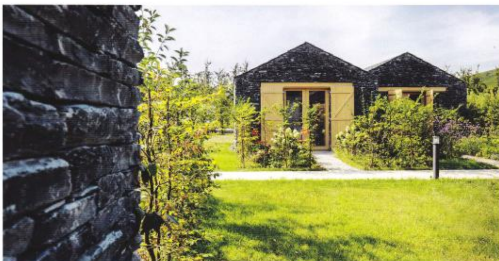
Langlebige regionale Baustoffe: Moselschiefer, Eichenholz aus dem Hunsrück, kurze Transportwege und lokale Verarbeiter prägen das Gesicht der Winzerhäuser des Weinkulturgutes Longen-Schlöder in Longüch. Die Winzerhäuser erhielten einen von vier Architekturpreisen Wein 2013. Architekten: Matteo Thun, Mailand, mit Stein von Hemmes Wirtz, Kassel.
